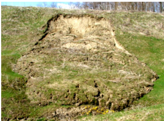
Foto 1 Alunecare superficială pe halda de la Valea Mănăstirii
